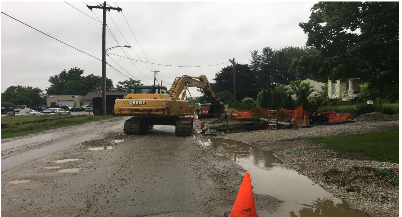
ATT structure excavation
